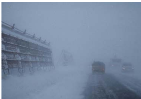
防雪柵（吹き払い柵）
