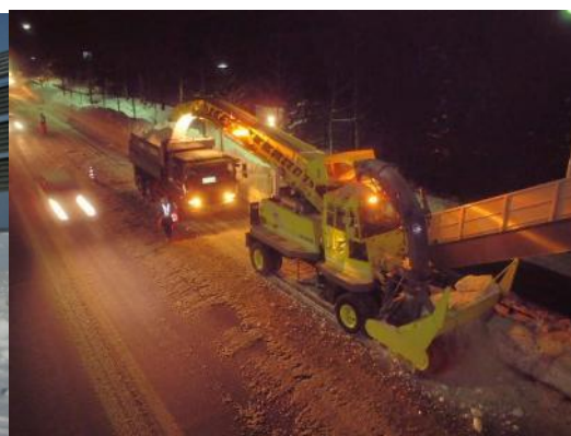
街中での運搬排雪作業
