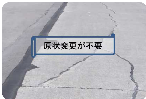
ひび割れ、目地を補修した事例
