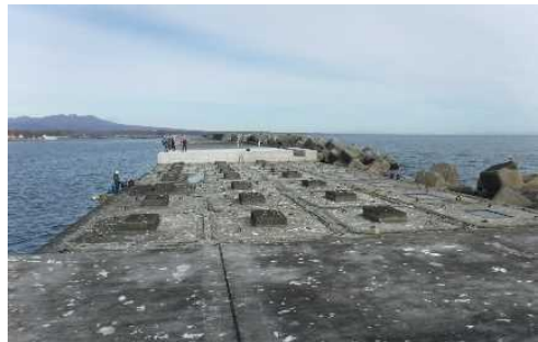
白老港の防波堤整備
