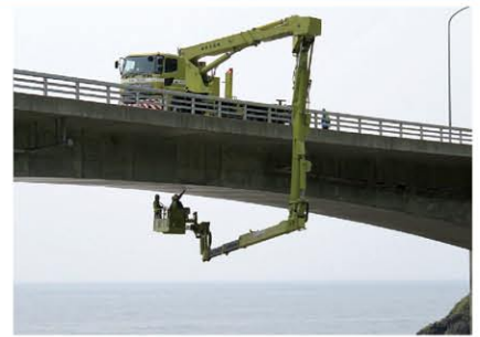
橋梁点検車による定期点検
