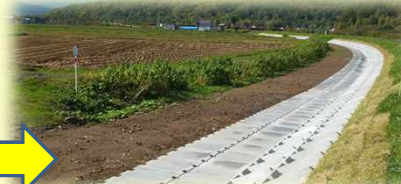
堤防法尻補強工事（継続実施）
