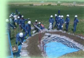
水防工法実技訓練
