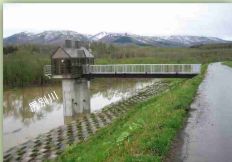
平成24年5月4日 増水時の三浦樋門
