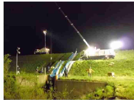
夜間訓練(淀川樋門にて)→
