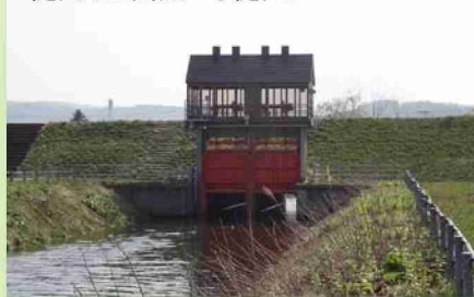
樋門(旧蘭越1号樋門)
