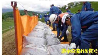
積み土のう工
