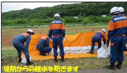
改良積み土のう工の設置状況
