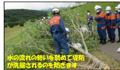
木流し工の設置状況
