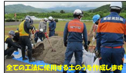
土のう作り工の作業状況
