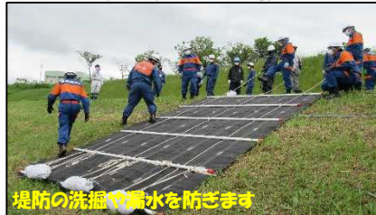
シート張り工の設置状況
