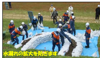
月の輪工の設置状況
