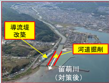
導流堤改築の実施状況
