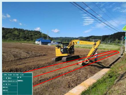
農業用排水路の施工状況
